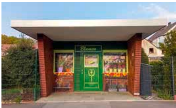
Einladend wie ein echter Blumenladen: Trafostation in Oer-Erkenschwick.
