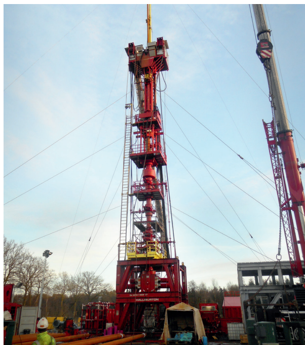
Snubbing-Anlage für Workover-Maßnahmen
